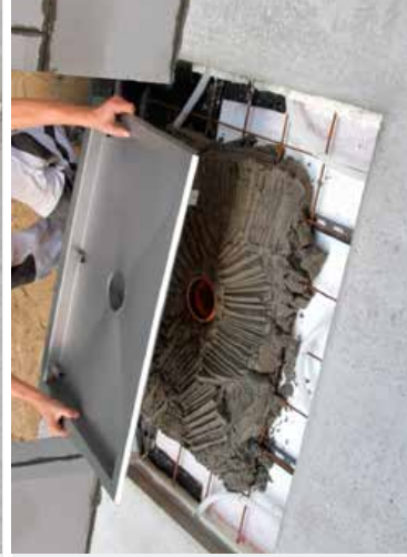
Asenna MatLine-lattiakaivokaluste viemäriputkeen ja paina kiinni märkään betoniin
