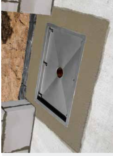
Kun MatLine-lattiakaivokaluste on oikein paikoillaan, se voidaan valaa kiinni
