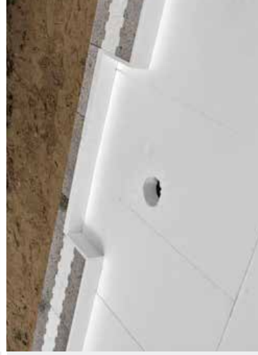
Zaizolować płytę naziemną zgodnie z obowiązującymi
