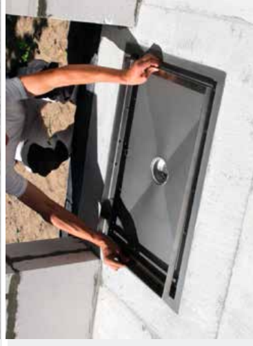
Asenna MatLine-kehys ennen laatoituksen aloittamista
