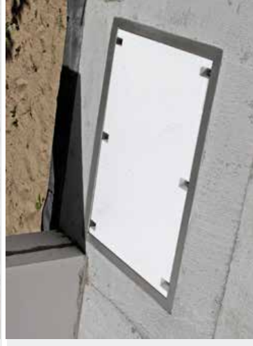
Vaahntomuovilevy voi olla asennuskohdassa siihen asti, kunnes MatLine-matto asennetaan
