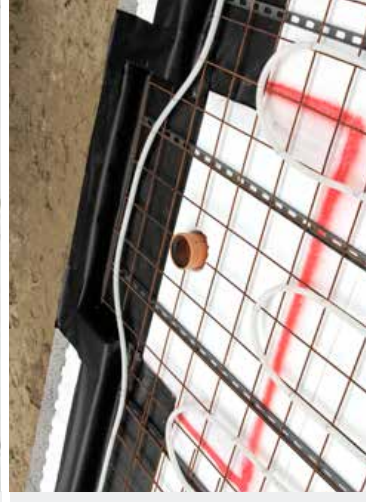
Położyć membranę radonową, siatkę wzmacniającą i podpodłogowe rury grzewcze
