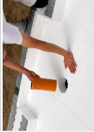
Włożyć odmierzoną na długość rurę do syfonu typu P
