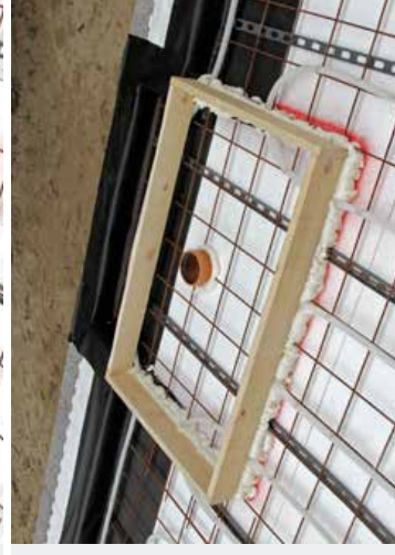
Wykonać wnękę (szerokość 1250 mm i głębokość 1000 mm) w betonie
