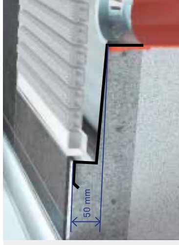
Ostateczną wysokość rury ściekowej mierzy się na poziomie 50 mm pod wykończoną warstwą betonową.
