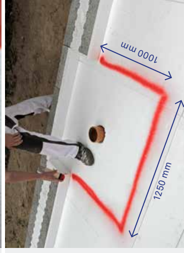
Oznaczyć położenie wnęki w betonie
